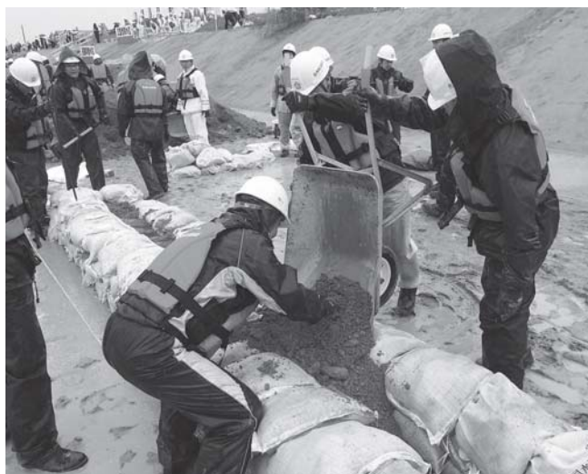
土のう積み工法を実施する邑南町消防団
