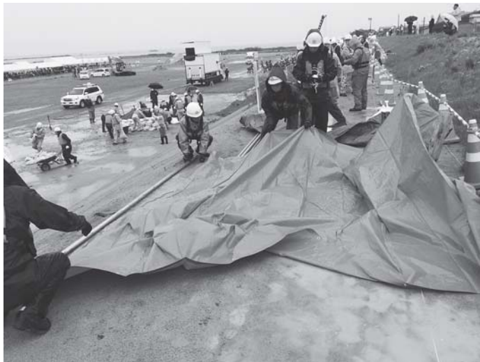
シート張り工法を実施する邑南町消防団
