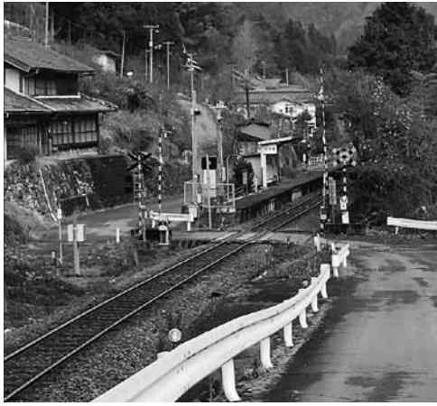
廃線後道路拡幅の要望がある 三江線江平駅付近
