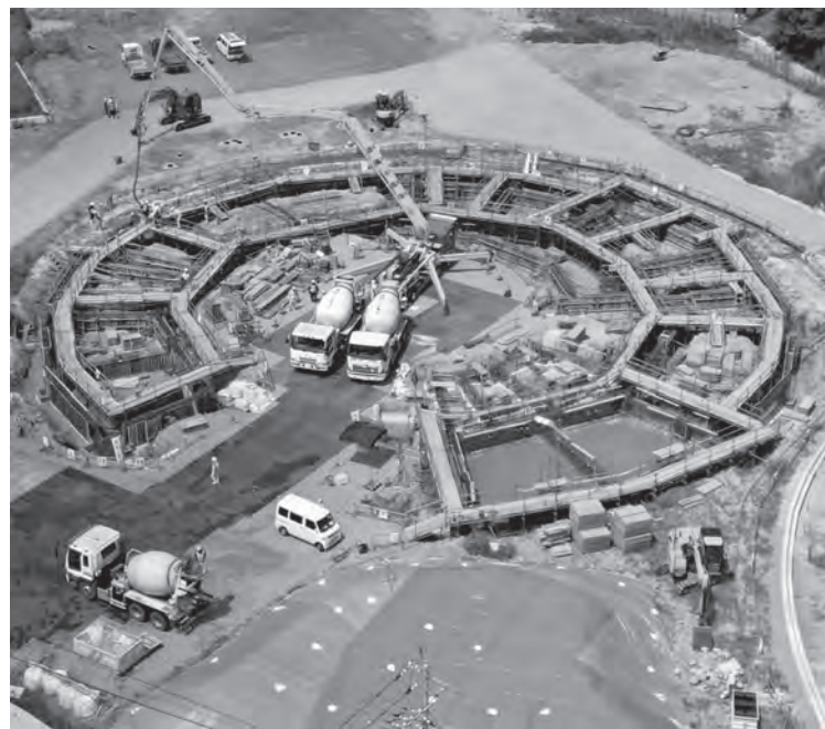
建設工事が進む道の駅「邑南の里」
