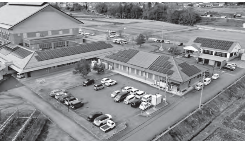
PPA事業で設置された太陽光発電施設
