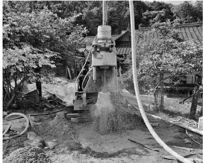
井戸のボーリング工事
