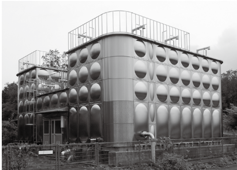
安全な水を供給するための給水施設（出羽配水池）
