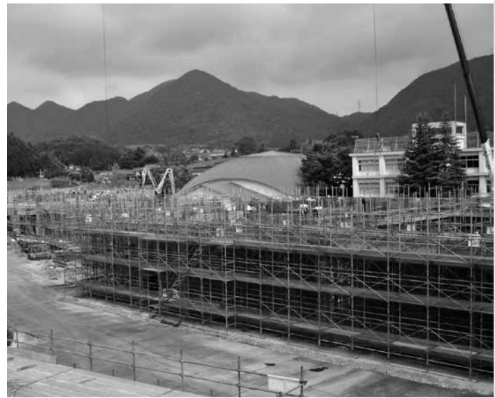
改築工事が進む石見中学校
