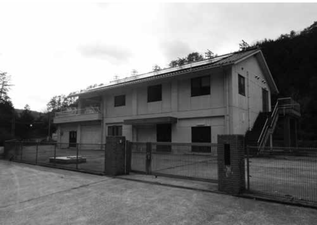
上田所浄水場
