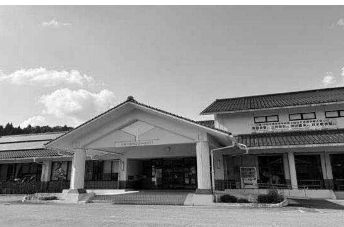
地域運営組織が始まった出羽公民館
