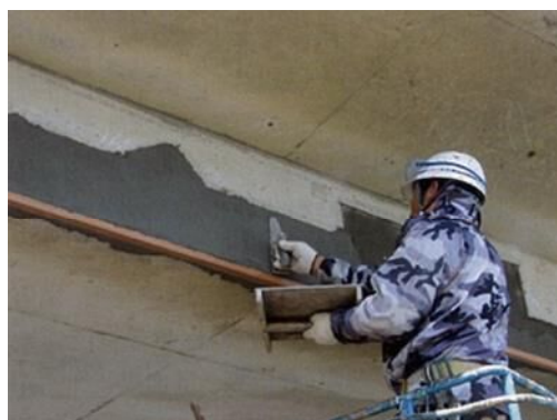
写真4-3 断面修復状況
