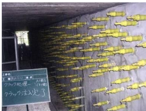
写真4-2 ひび割れ注入状況
