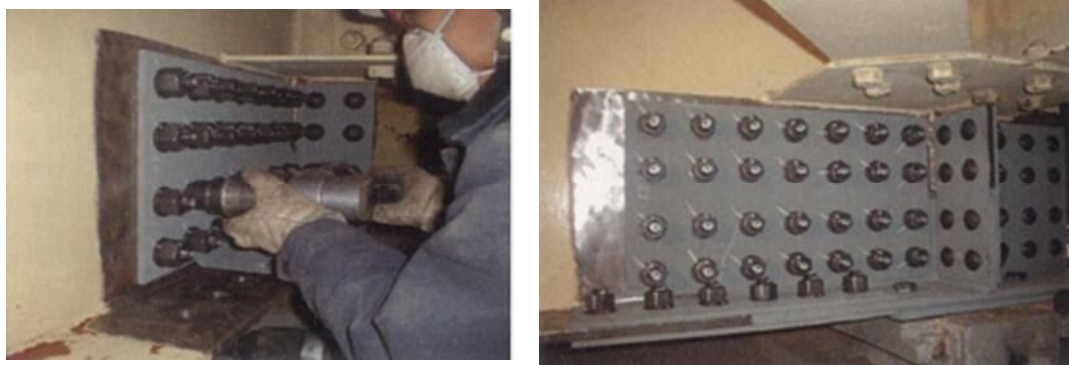
写真4-1 当て板工実施状況
