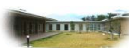
知的障害者更生施設 緑風園 (90) (ショートステイ4)
