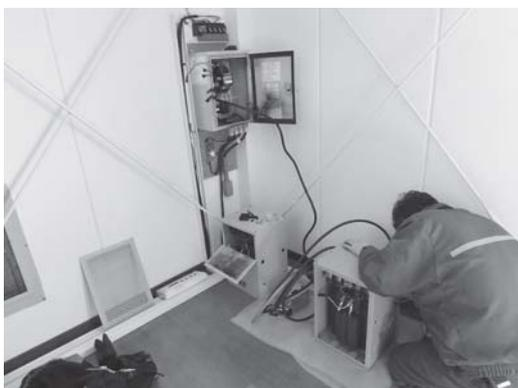
平成29年2月には落雷により原山中継局の計器が故障。対応作業にあたる様子。
