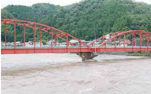
7月13日未明から降った豪雨で増水した江の川(口羽地区 両国橋)
