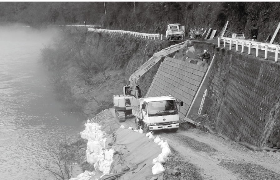
順調に進む災害復旧工事
