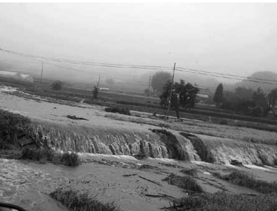
堤防を越え農地に氾濫した濁流
