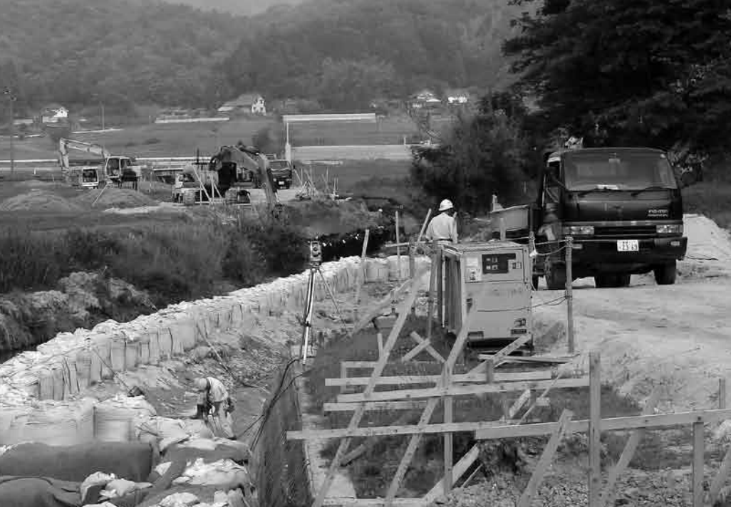
本格化した災害復旧工事
