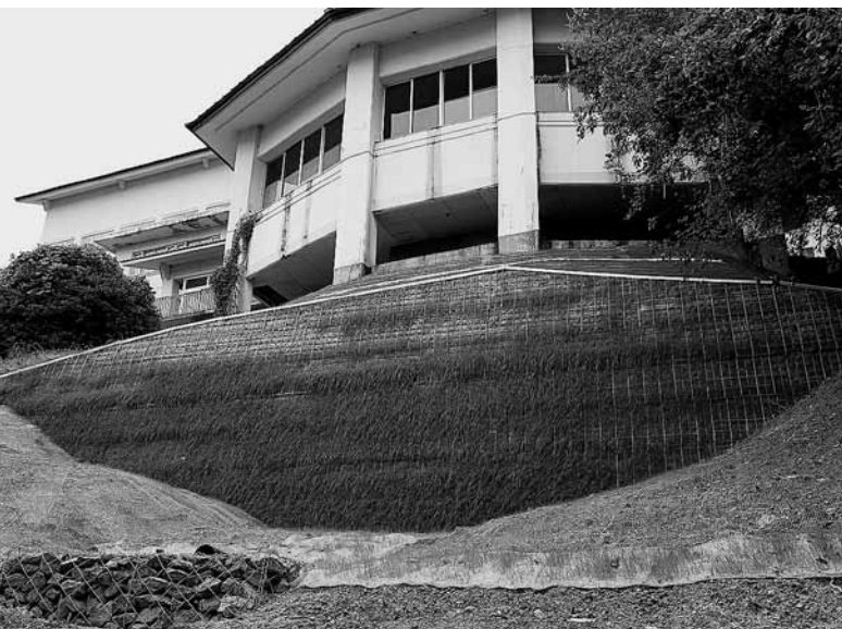
災害復旧工事が完了した浴室棟脇の法面
