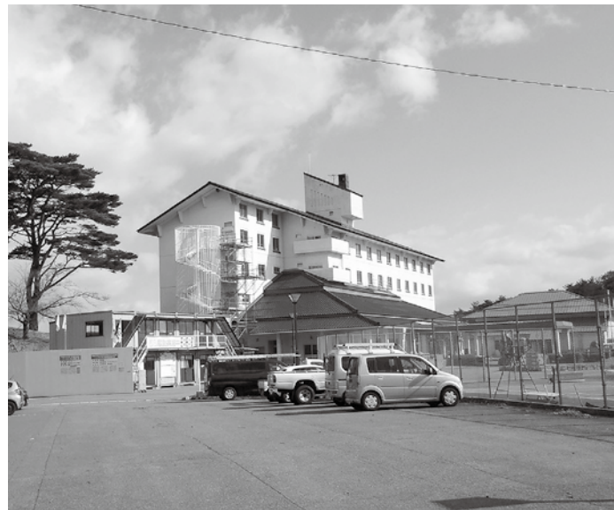
改修工事が進む「いこいの村しまね」
