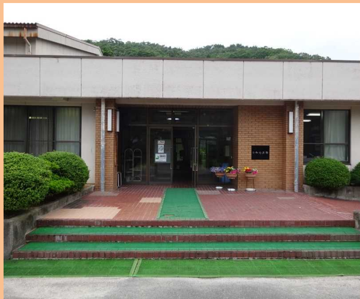
玄関タイルも修繕が済みきれいになった正面玄関
