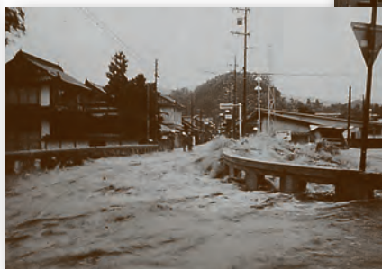
▼濁流に耐える出羽橋
