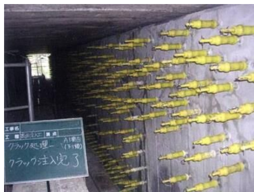
写真 4－2 ひび割れ注入状況
