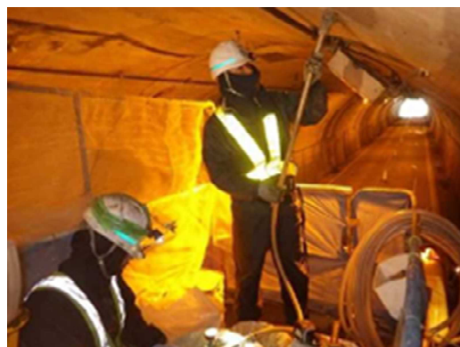
裏込注入状況
