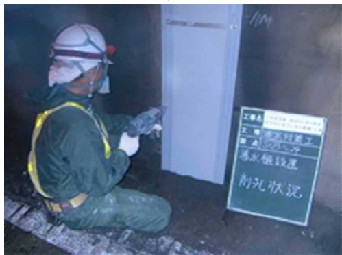
写真3-2 線導水工
