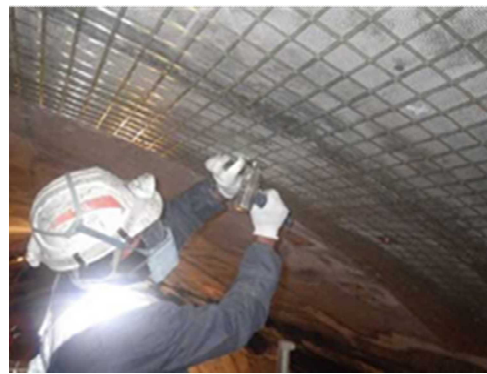
FRPネット設置状況
