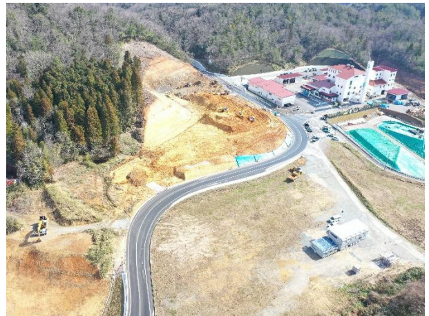
【施工中 令和2年3月撮影】
