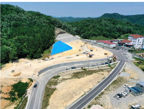
【施工中 令和2年6月撮影】
