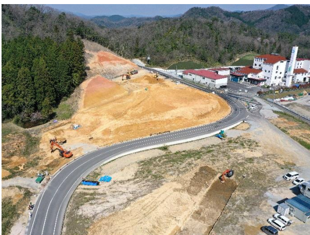
【施工中 令和2年4月撮影】
