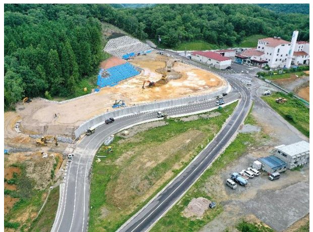
【施工中 令和2年7月撮影】
