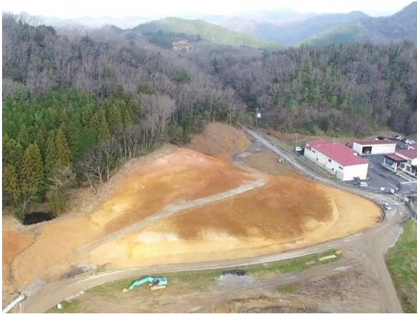
【着工前 平成30年12月撮影】
