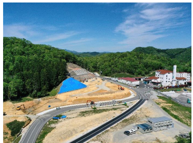
【施工中 令和2年5月撮影】
