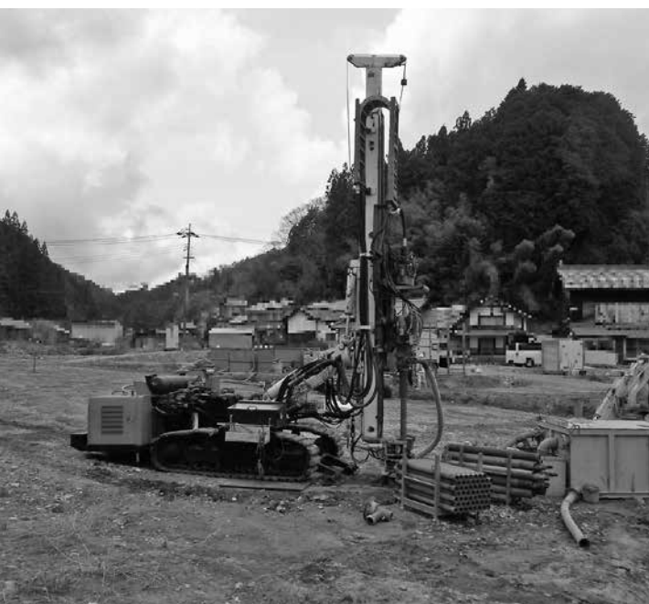
地中熱利用のさく井工事が 始まった、道の駅再整備
