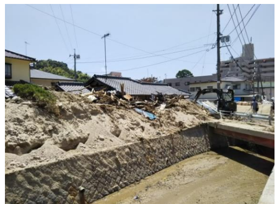
写真 2-4 民地に流入した土砂 (平成 30 年 7 月豪雨 広島県呉市)
