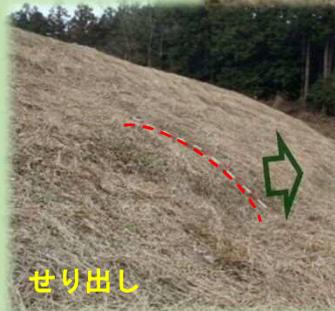
土手の浸食が進むと、土手が痩せて崩れやすくなる。
