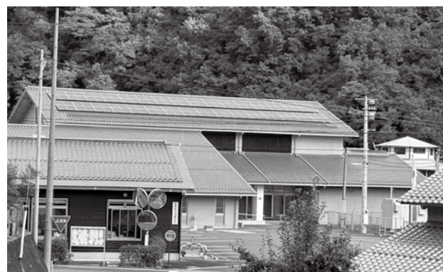
太陽光パネルを設置した口羽公民館
