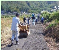
未舗装農道の舗装
