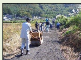
未舗装農道の舗装
