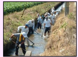
水路の泥上げ
