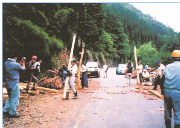
写真 5-12 間伐材を利用した坑口枠作り
